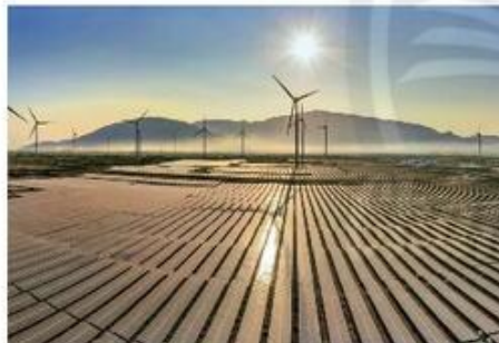
f) Trạm phát điện gió
