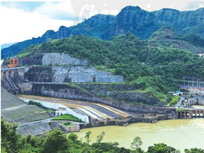
c) Nhà máy thủy điện (Hoà Bình)
