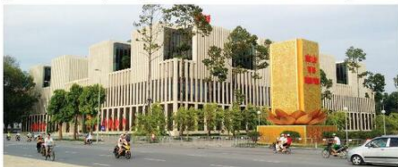
▲ Hình 11.9. Toà nhà Quốc hội sử dụng vật liệu xây dựng xanh
