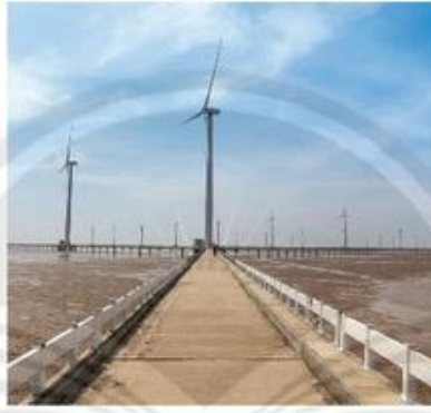
b) Trạm phát điện gió (Bạc Liêu)
