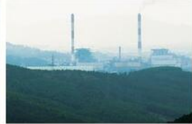
▲ Hình 10.8. Nhà máy nhiệt điện
